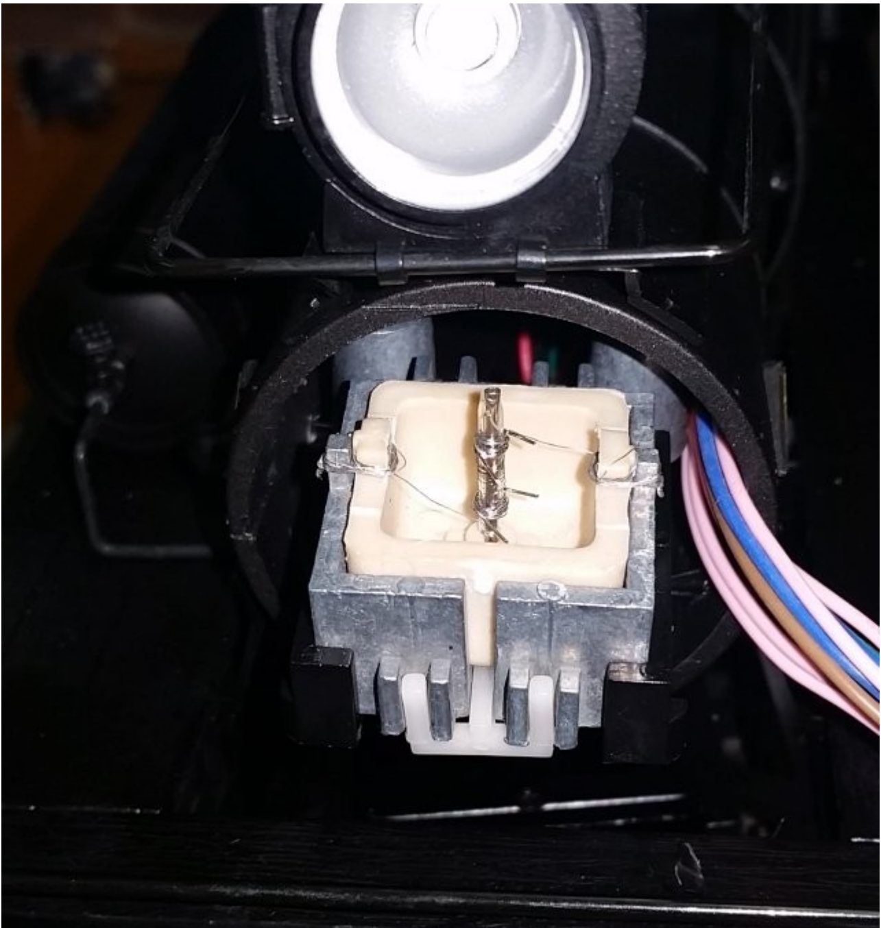
Bild 6: Ausbau alter Verdampfer
